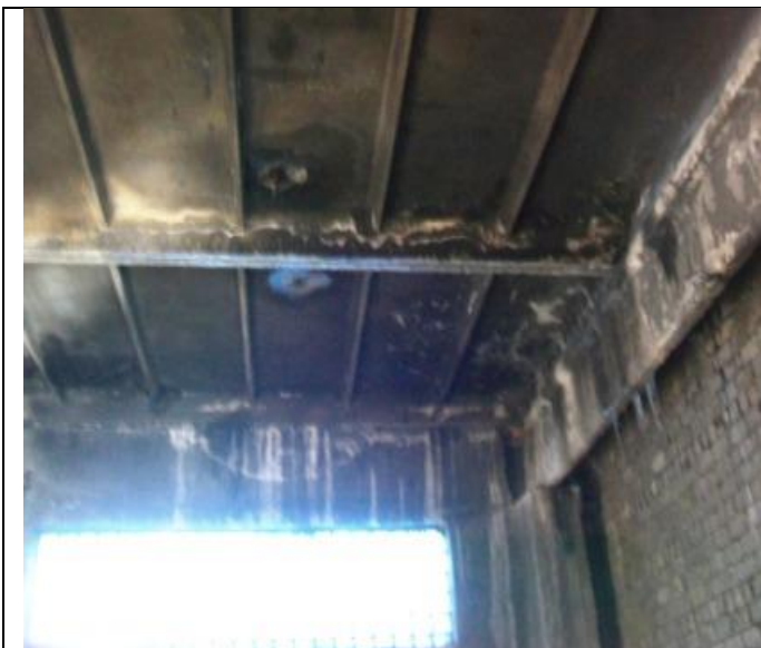
Котельная по Куйбышева 14, Перекрытие склада угля
