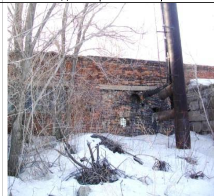
Котельная по Куйбышева 14, Вид с севера
