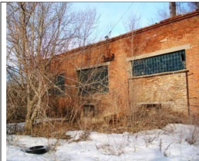
Котельная по Куйбышева 14, Вид с юго-востока
