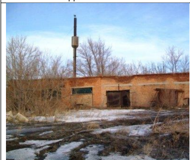
Котельная по Куйбышева 14, Вид с юга
