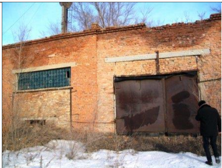
Котельная по Куйбышева 14, Вид с юго-востока
