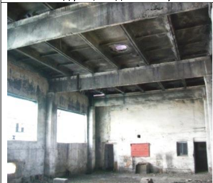
Котельная по Куйбышева 14, Перекрытие зала для котлов
