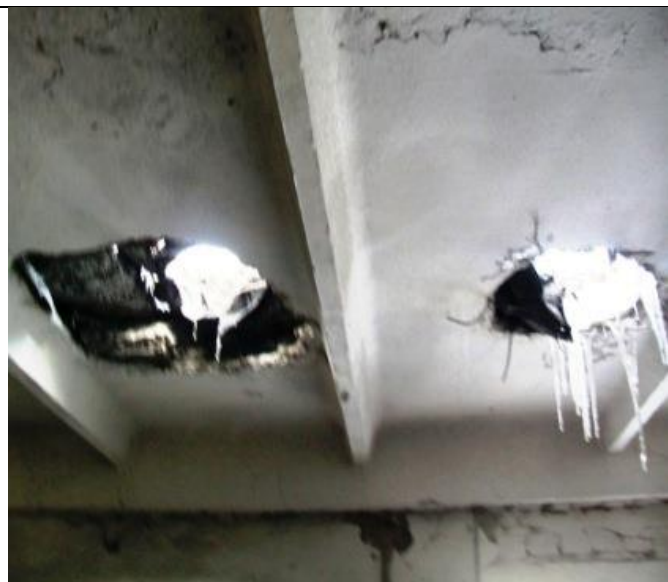
Котельная по Куйбышева 14, Перекрытие насосной
