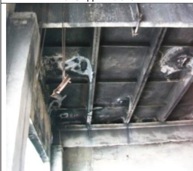
Котельная по Куйбышева 14, Перекрытие зала для котлов
