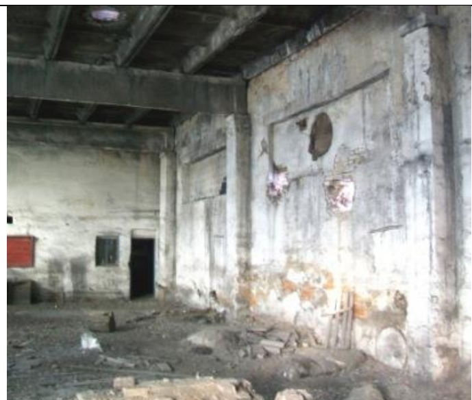
Котельная по Куйбышева 14, Северная стена
