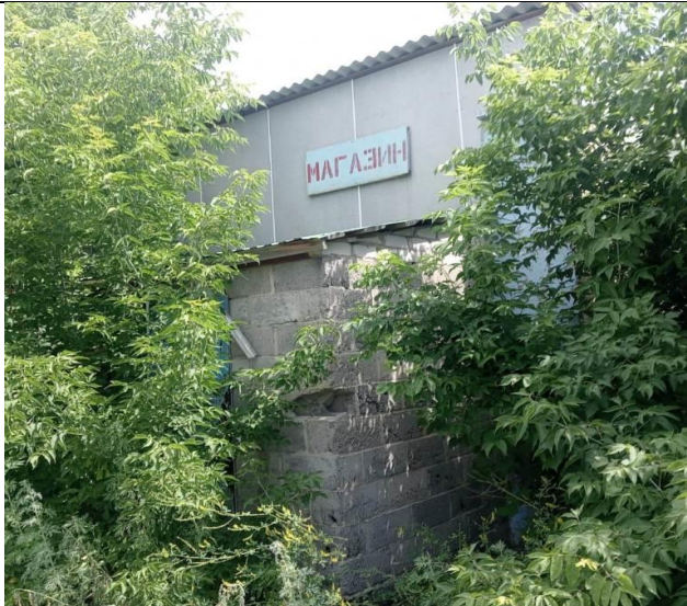
Здание магазина в Половинкино, Главный вход с юго-запада
