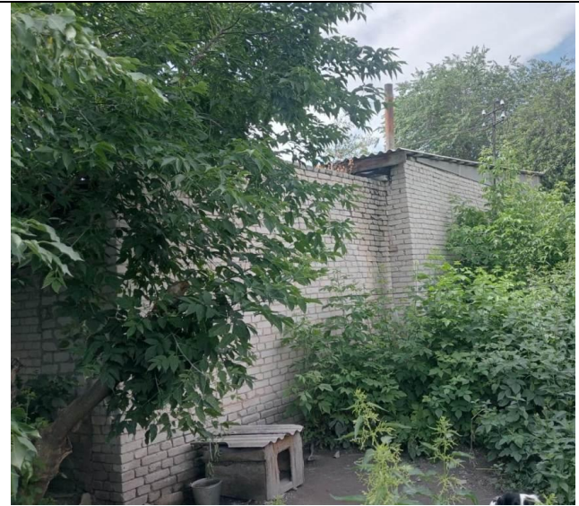
Здание магазина в Половинкино, Холодный склад с востока
