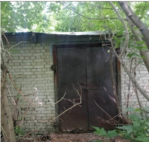
Здание магазина в Половинкино, Вход в холодный склад
