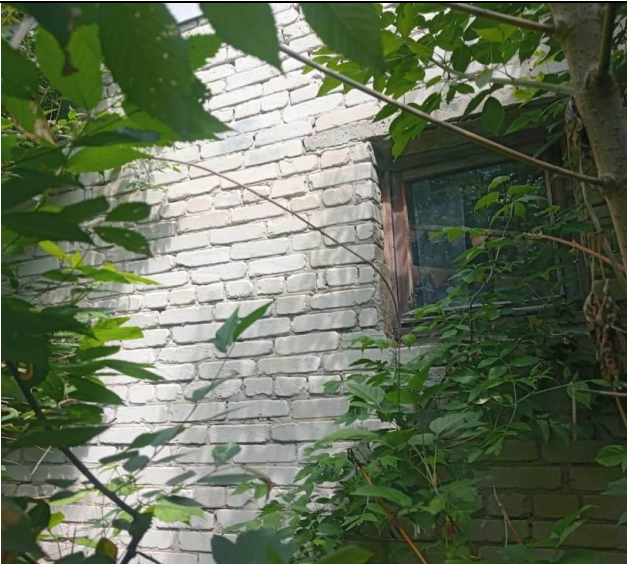
Здание магазина в Половинкино, вид с востока
